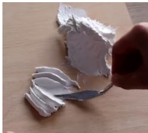
Рисунок 13-Работа мастихином при формировании мазков декоративной штукатуркой.
