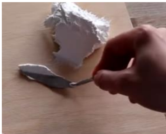
Рисунок 13-Работа мастихином при формировании мазков декоративной штукатуркой.
