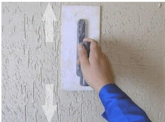
**Сушка.** Наилучшие условия для высыхания короеда – температура от 5 до 30 градусов и относительная влажность, не превышающая 80%. Наружную штукатурку выполняют при отсутствии дождя, ветра и прямых солнечных лучей – тогда она не потрескается. После окончания работ фасад покрывают полиэтиленовой пленкой, которая остается на фасаде в течение 2-х суток, предохраняя свеженанесенное покрытие от дождя, росы и солнца.
