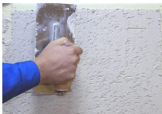
Раствор кладут равномерным слоем, выжидают 15–20 минут до окончания структурирования. Чем выше температура воздуха, тем раствор схватывается быстрее. Момент схватывания важно не пропустить, иначе поверхность нельзя будет протереть. Проведя пластмассовой теркой по стене, проверяют, можно ли приступать к затирке. Если штукатурка не пристает к инструменту, то начинают следующий этап.
