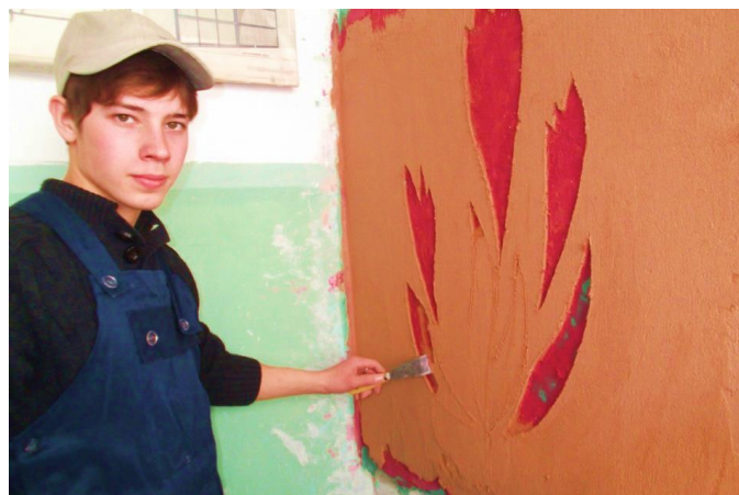
Рис.3 - Процесс выполнения штукатурки сграффито
