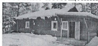
Рис. 18. Общий вид здания
