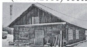
Общий вид здания
