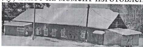
Рис. 8. Общий вид здания
