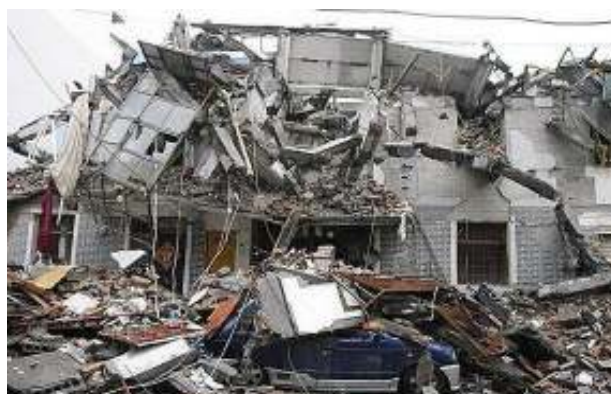
Рисунок 2 - Последствия землетрясения в Китае, 2010 г
