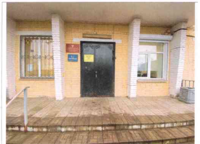
Фото №6 – Входная дверь главного входа.
