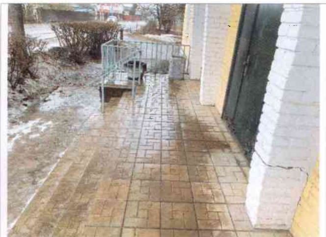
Фото №5 – Входная площадка главного входа.
