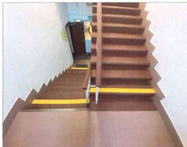
Фото №10 – Пути движения внутри здания (лестницы).
