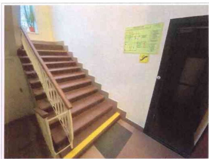
Фото №9 – Пути движения внутри здания (лестницы).
