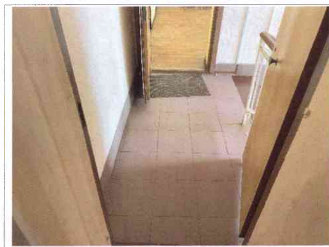
Фото №12 – Пути движения внутри здания (двери).
