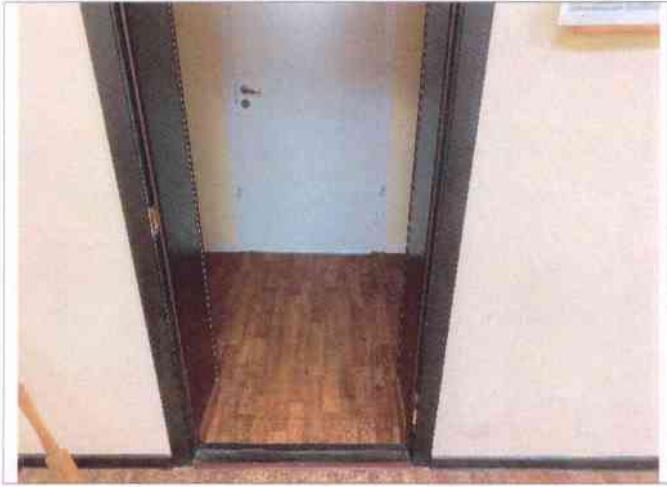
Фото №13 – Пути движения внутри здания (двери).
