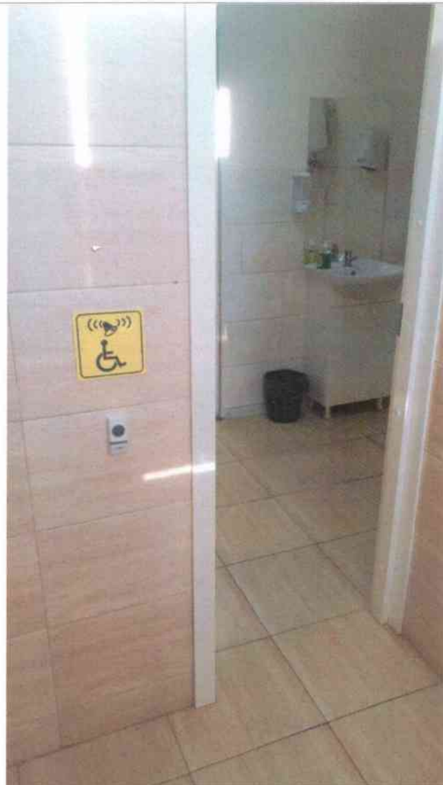
Фото №30 – Санитарно-гигиенические помещения. Кнопка вызова.
