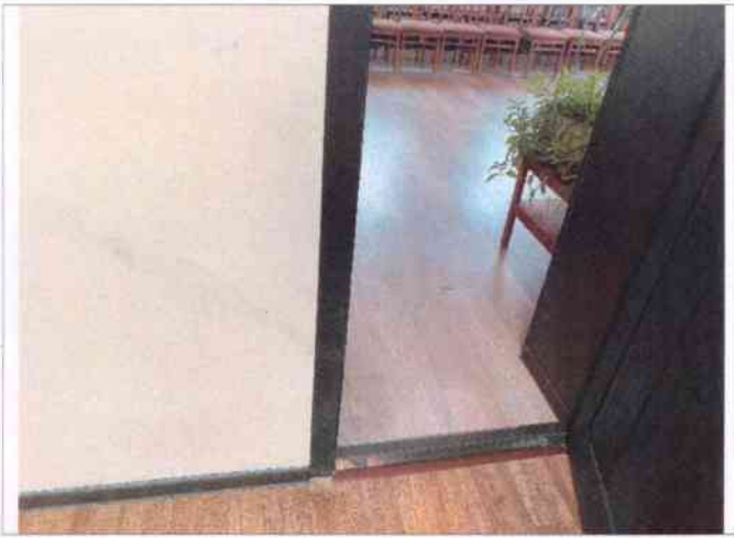
Фото №15 – Пути движения внутри здания (двери).
