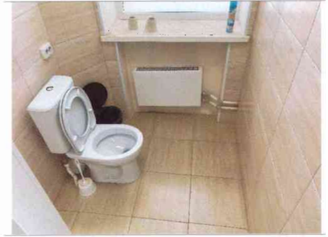
Фото №28 – Санитарно-гигиенические помещения
