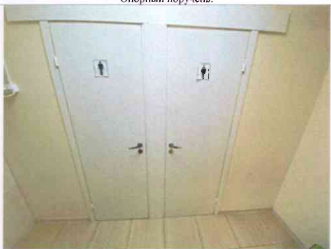
Фото №31 – Санитарно-гигиенические помещения
