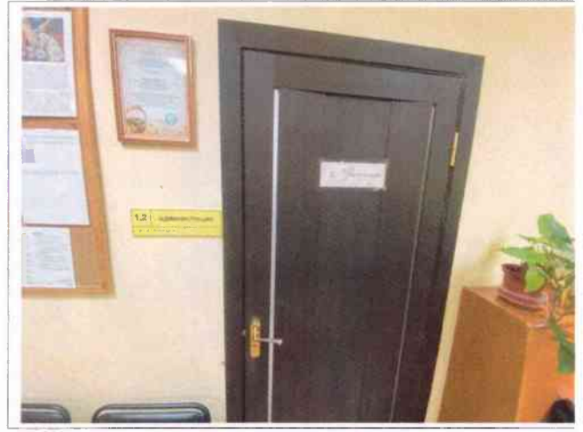
Фото №14 – Пути движения внутри здания (двери).
