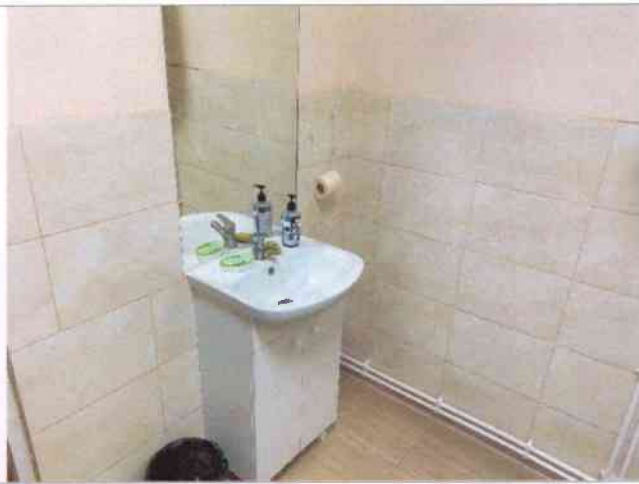
Фото №27 – Санитарно-гигиенические помещения
