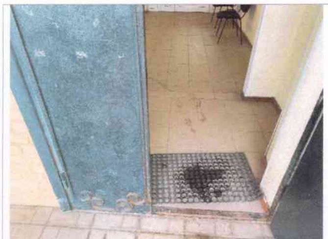
Фото №7 – Входная дверь, главного входа.
