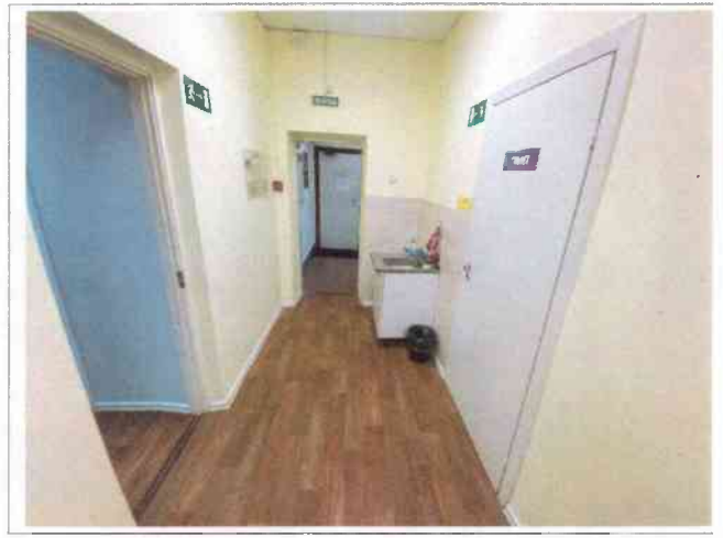
Фото №16 – Пути движения внутри здания (двери).
