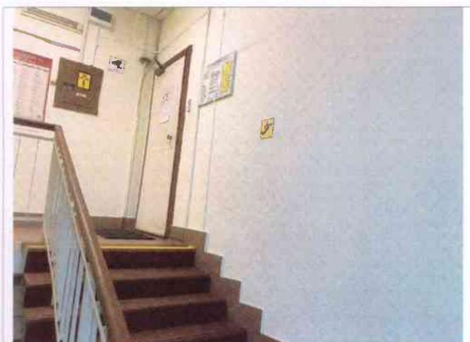
Фото №11 – Пути движения внутри здания (лестницы).
