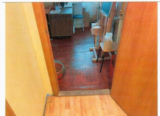
Фото № 17 – Пути движения внутри здания (двери).
