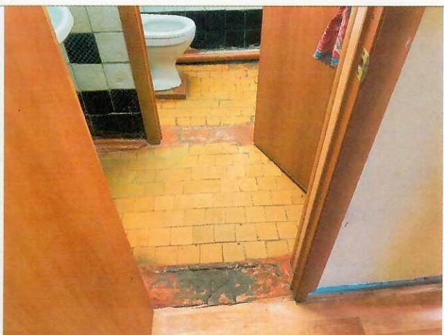
Фото № 21 – Санитарно-гигиеническое помещение
