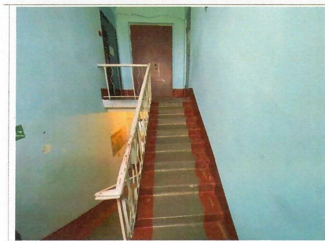
Фото № 12 – Пути движения внутри здания (лестница).
