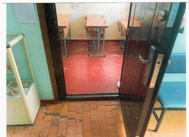
Фото № 15 - Пути движения внутри здания (двери).
