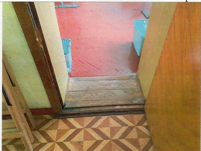
Фото №19 – Пути движения внутри здания (двери).
