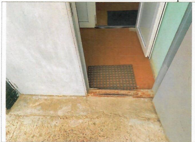
Фото № 7 – Внешняя входная дверь.
