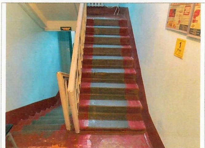
Фото № 11 – Пути движения внутри здания (лестница).
