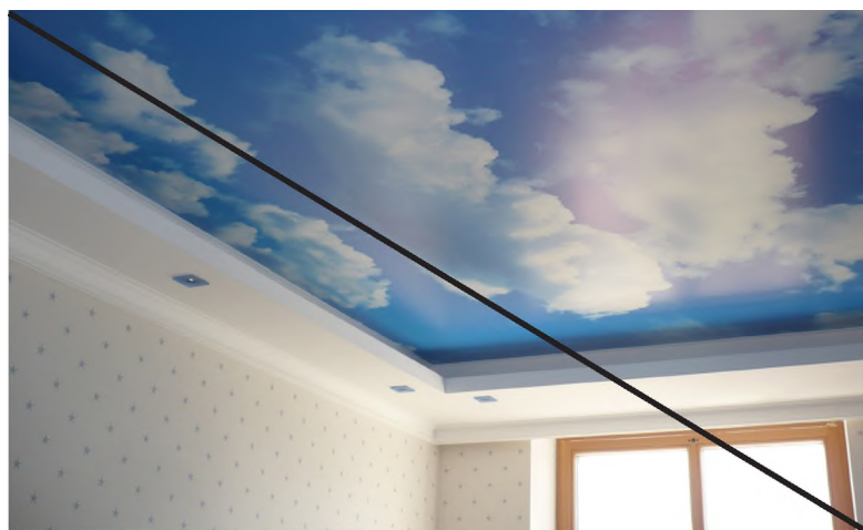
Плохо Натяжные потолки. Потолки с рисунками
