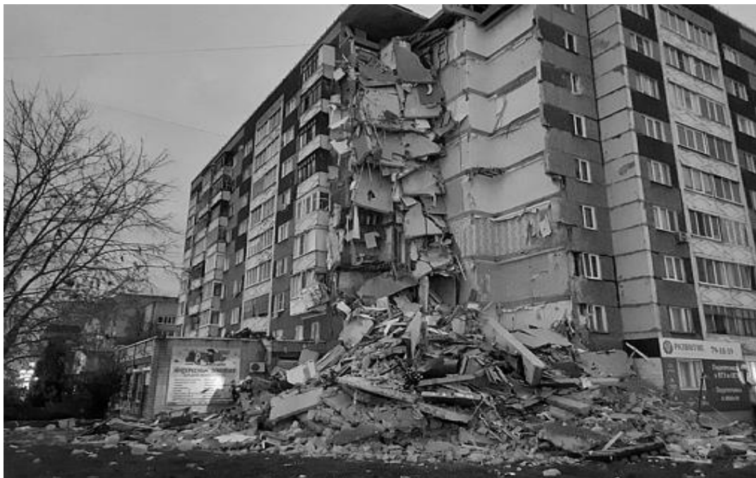
Рисунок 4 – Взрыв газа в угловой квартире крупнопанельного многоквартирного жилого дома в Ижевске, 9 ноября 2017 [ https://ru.wikipedia.org/wiki/Взрыв_жилого_дома_в_Ижевске#/media/File:Взрыв_жилого_дома_в_Ижевске.png ]
