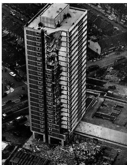
Рисунок 2 – Общий вид и схема обрушения угловой части крупнопанельного 24-х этажного жилого дома, Лондон, 1968 г. [ http://mixstuff.ru/wp-content/uploads/2013/06/119.jpg ]
