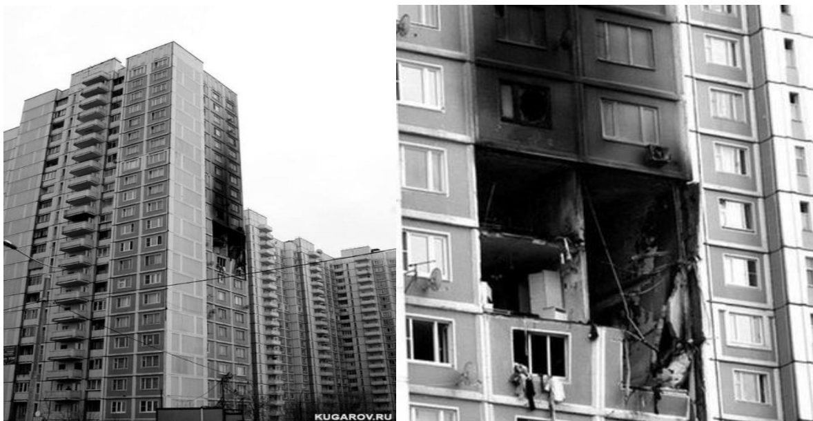
Рисунок 5 – Взрыв в 22-этажном жилом негазафицированном доме в Москве в 2008 г., где произошло обрушение внешних конструкций дома на 10-м, 11-м и 12-м этажах здания, обрушение межэтажных перекрытий [ http://zagony.ru/2008/04/07/pozhar_na_ulice_akademika_koroleva_9_fot.html ]
