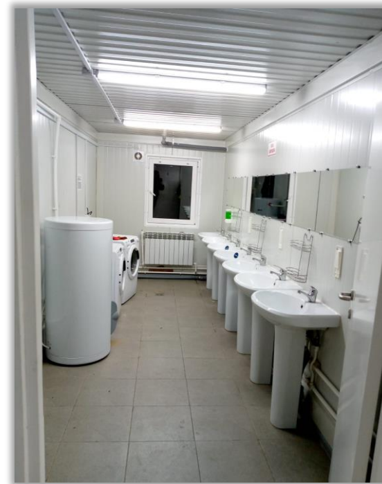
Сушильная комната, оборудованная стиральными машинками.
