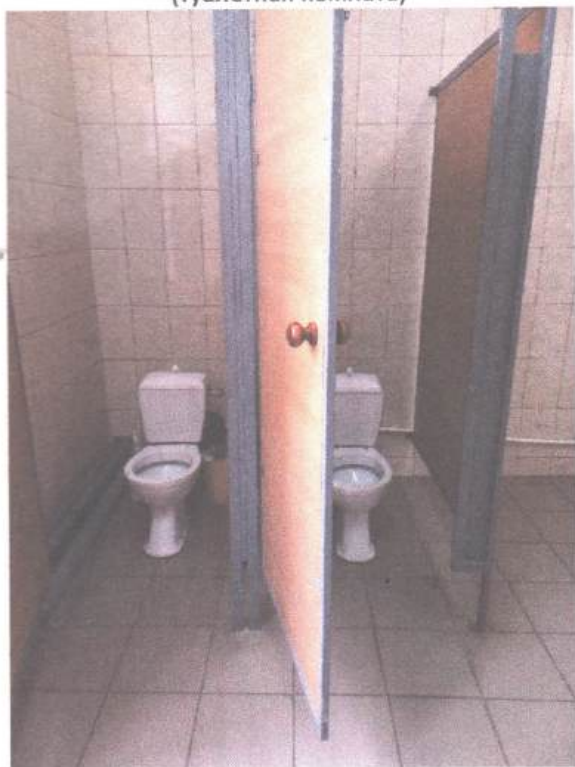
№53. Санитарно-бытовые помещения (туалетная комната)
