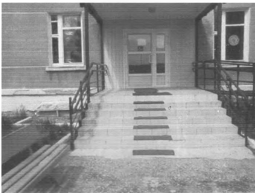
фото № 3 лестница (наружная). входная дверь, новый навес
