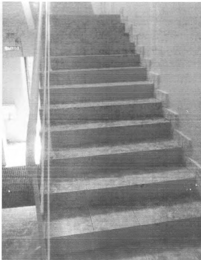
фото № 14 лестница (на 2-й этаж, в гостиные номера)
