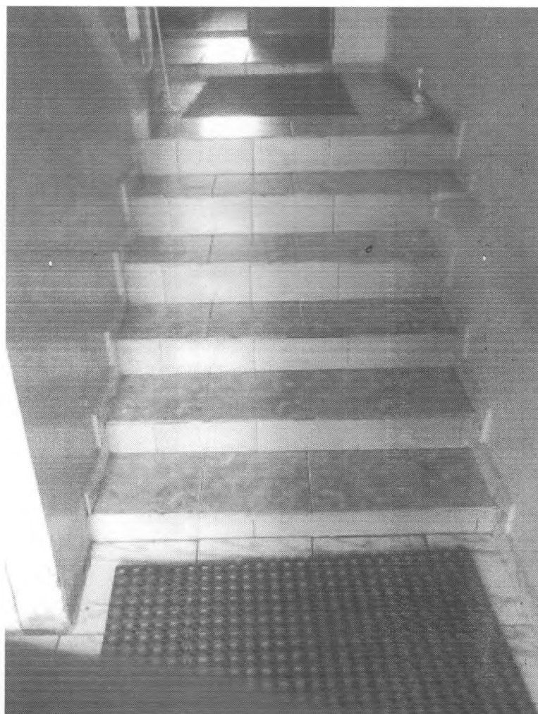
фото № 13 лестница (внутри здания) на 2-м входе/выходе
