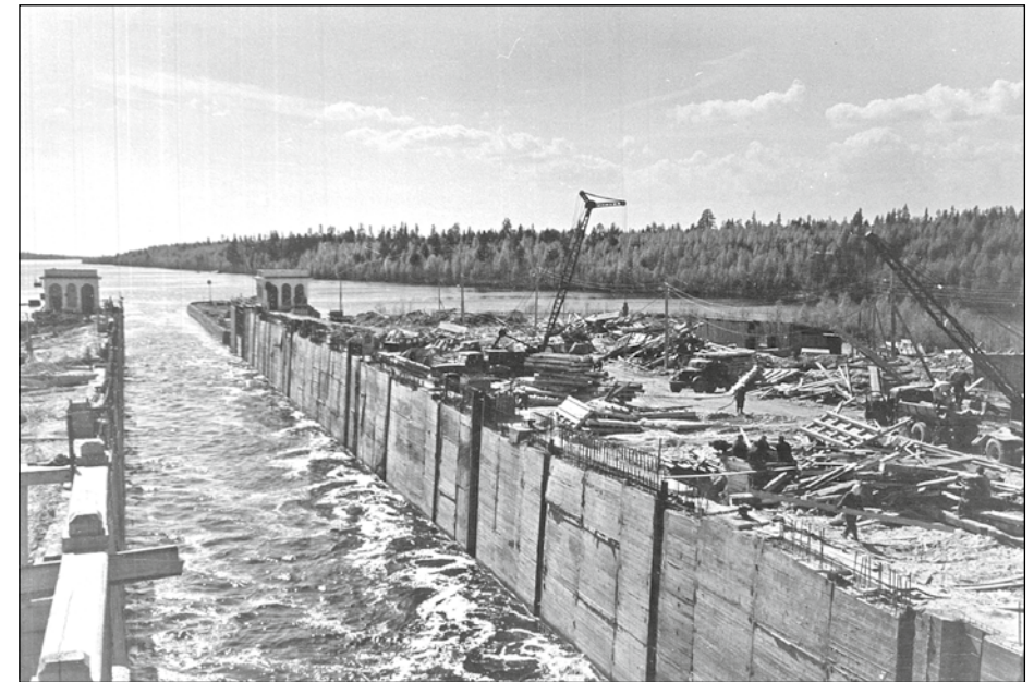
Промывка камеры после завершения реконструкции
