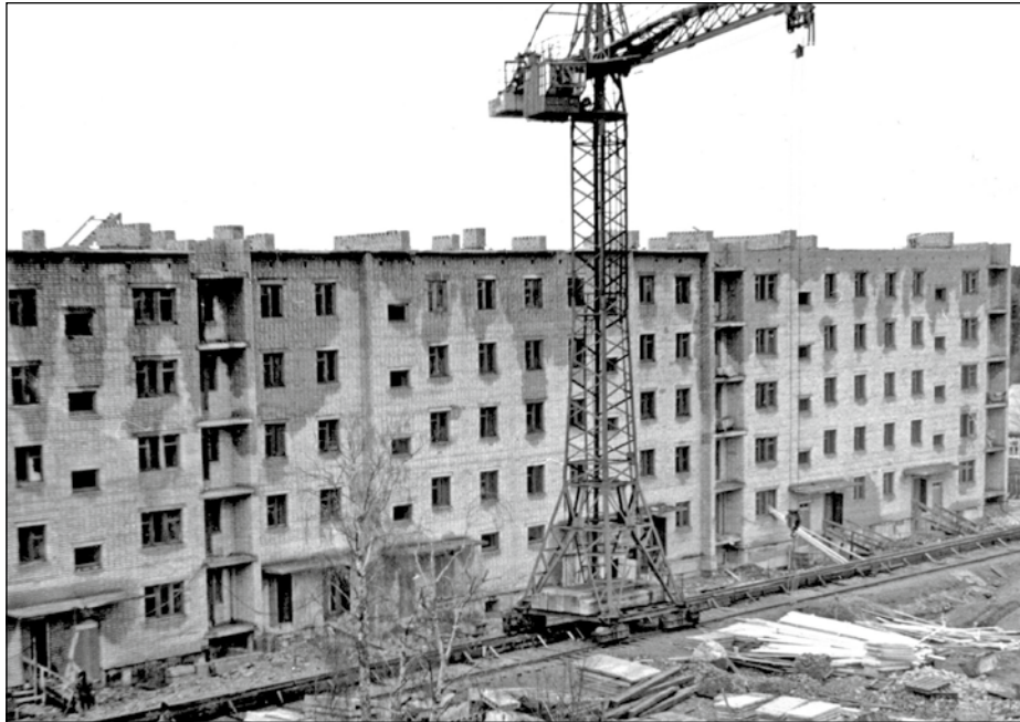
Строительство дома в п.Повенец
