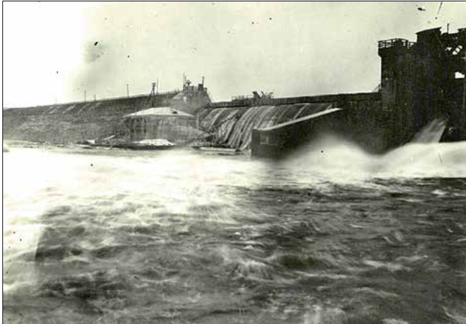
Плотина №27 в момент наращивания ледопрпускной части. 1952 г.
