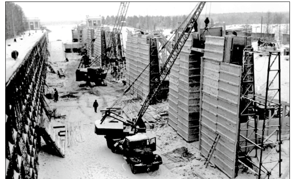
Реконструкция камеры шлюза №8
