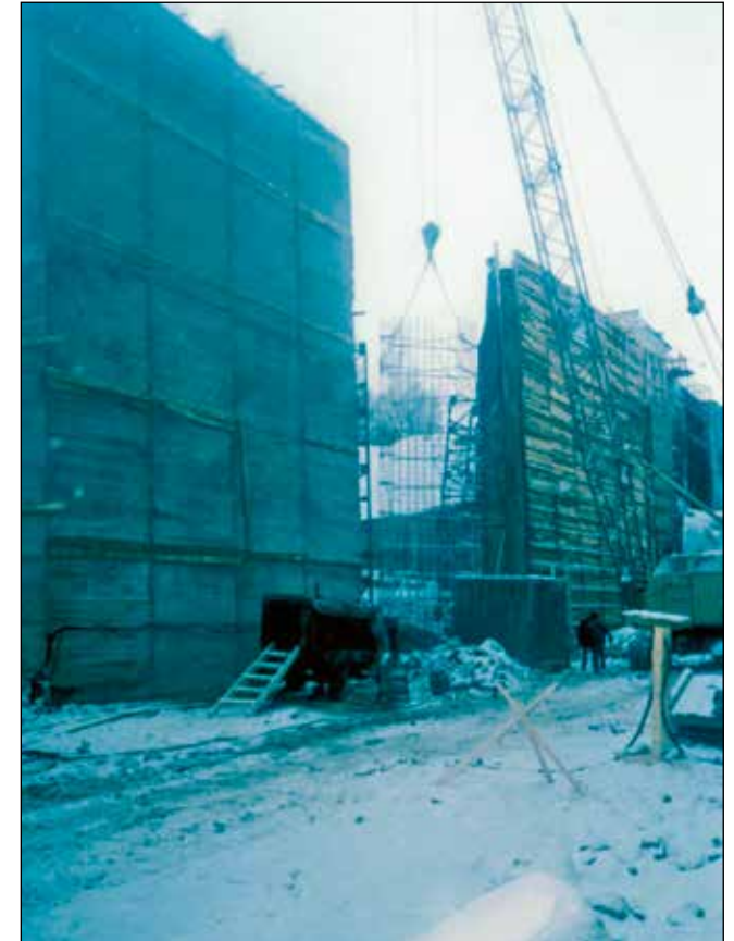
Замена ряжевой стены камеры на бетон
