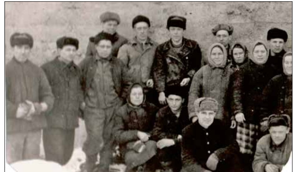
Бригада эксплуатационников шлюза №№16-17 на ремонте шлюза в зимних условиях
