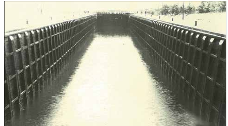
Вид шлюза до реконструкции
