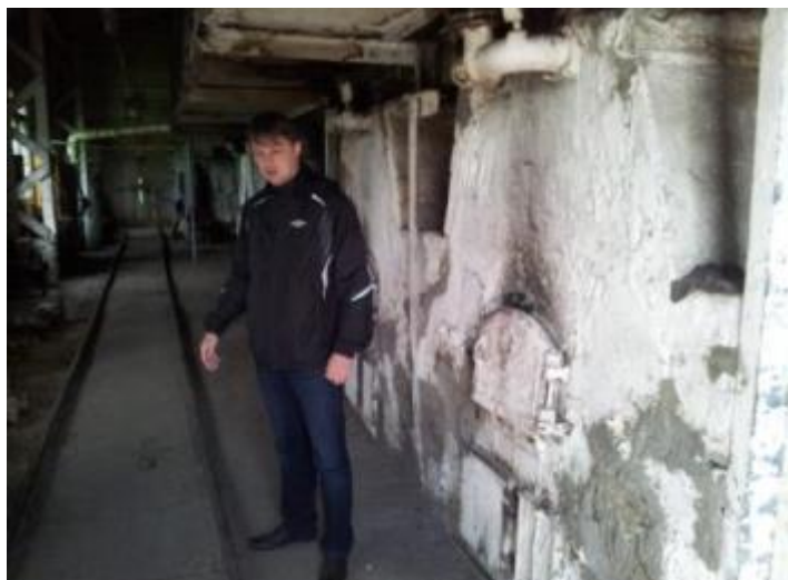
Рисунок 13: Старые котлы с ручной подачей дров, Реболы
