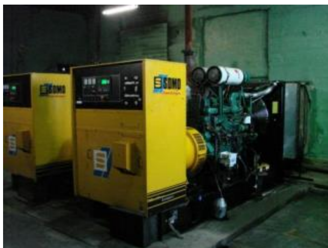
Два эксплуатируемых дизельных генератора
