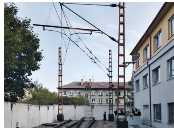
Полигон Техническое обслуживание устройств электроснабжения
