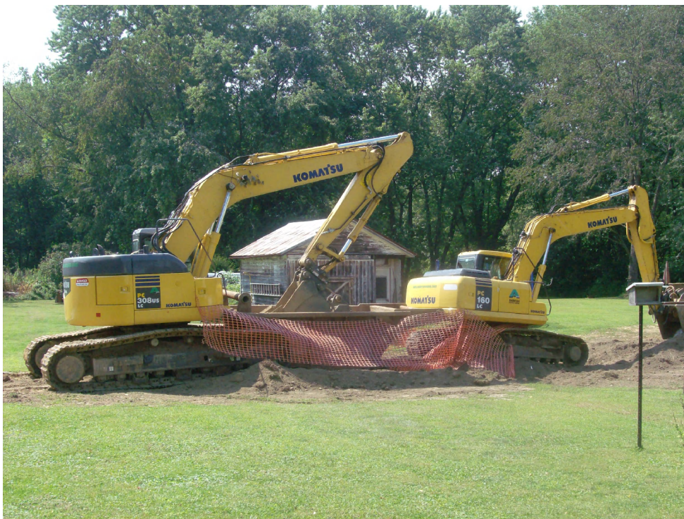
Figure 10. Экскаваторы, объединенные в би-систему
