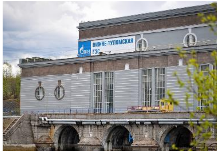
Каскад Тулумских ГЭС, 1993 год
