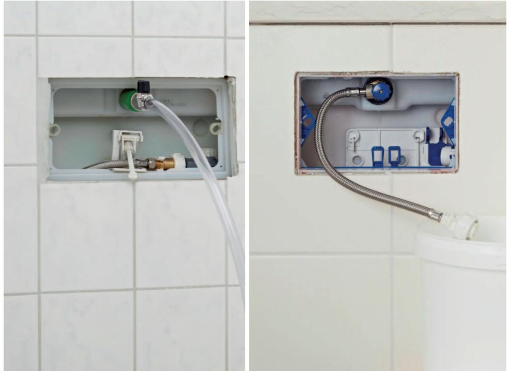
Abb. 13: WC-Spülkasten (demontiertes Eckventil) mit Baustopfen und Spülarmatur
