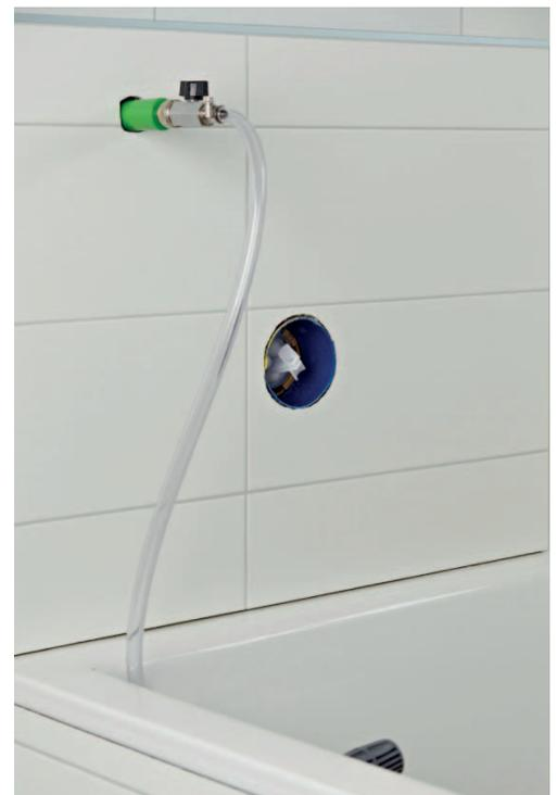
Abb. D-12: Entnahmestelle an Badewannen-Armatur mit Baustopfen und Spülarmatur, sowie Spüleinsatz des Armaturenherstellers in der Unterputzarmatur zur getrennten Spülung der Kalt-/Warm-Wasserleitungen.
