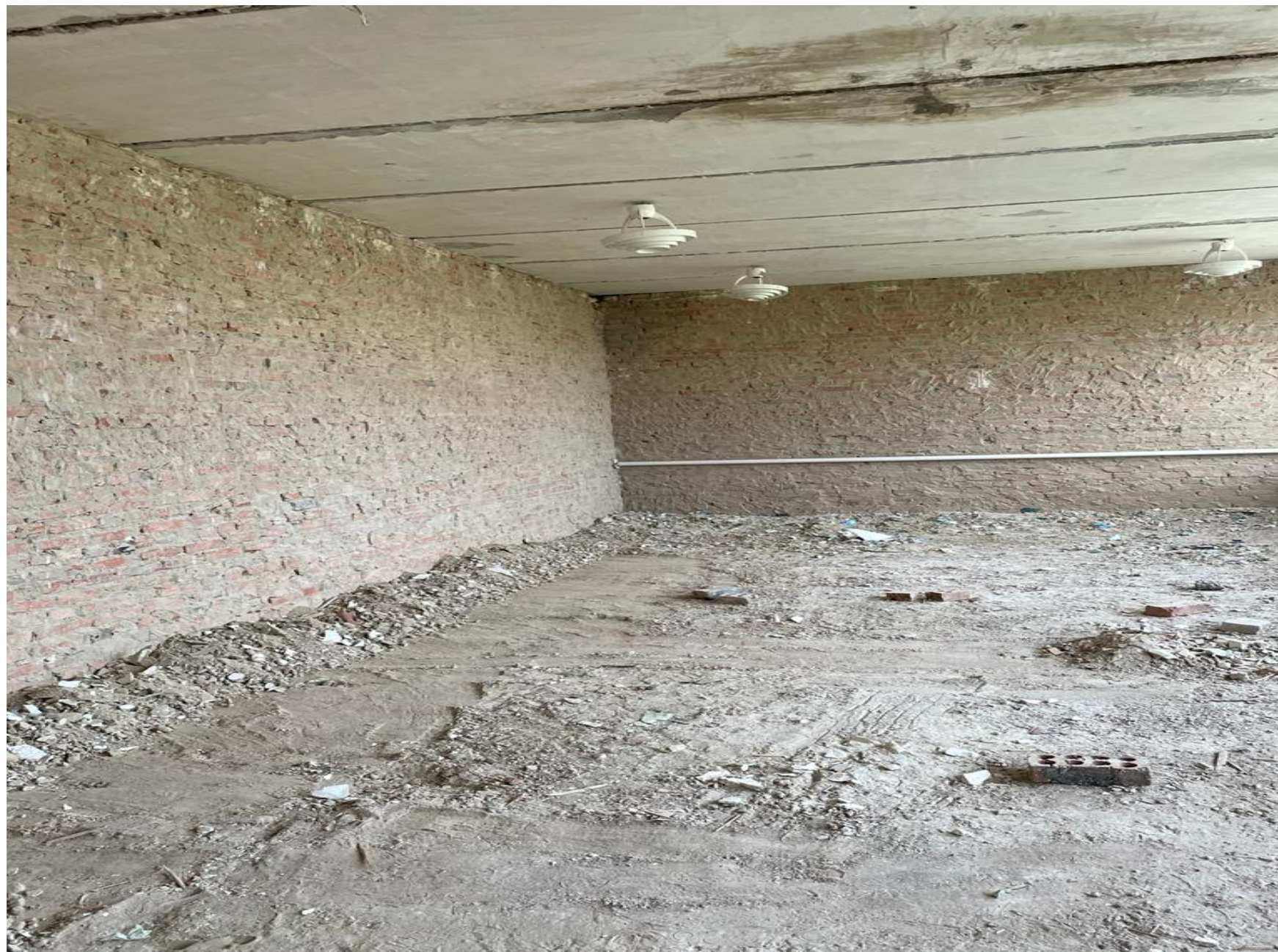
Во время капитального ремонта школы
