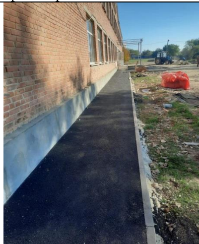
12. Асфальтирование отмостки
