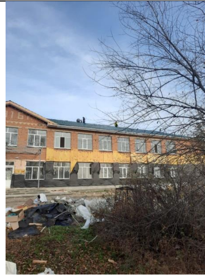
5. Фасад (сайдинг) утепление стен под сайдинг, монтаж сайдинга
